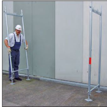
Встановлення вертикальної рами
